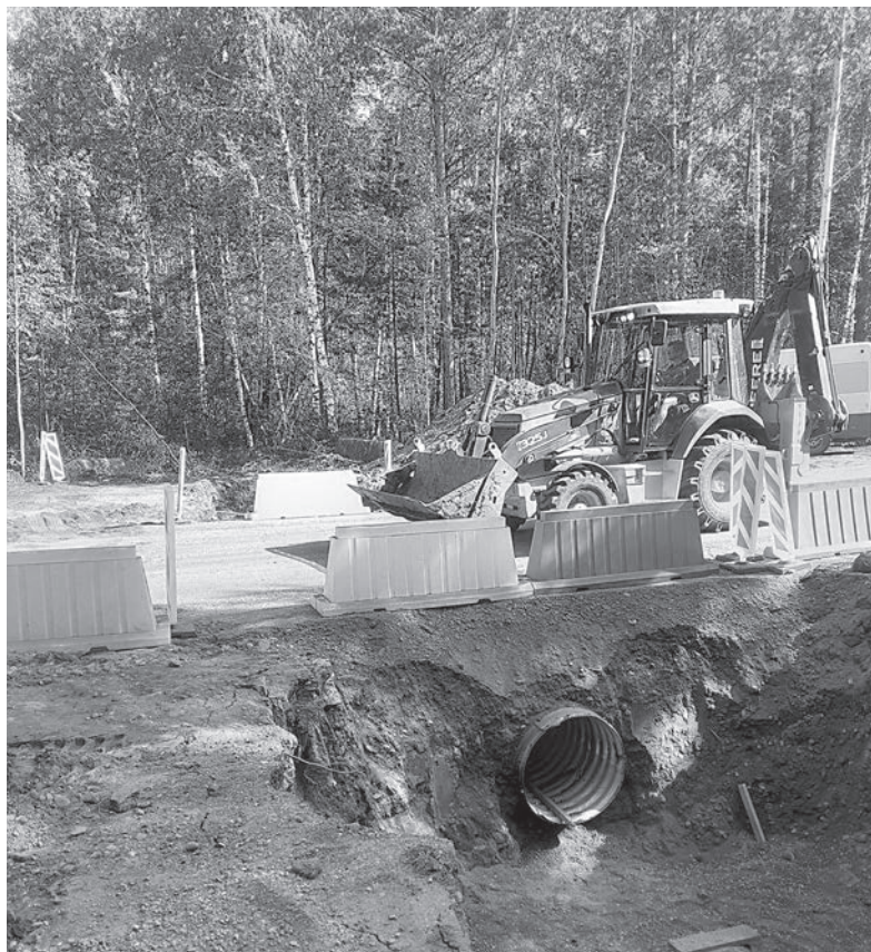
Решён основной технологический момент - перекладка водоотводной трубы на низком участке рельефа
