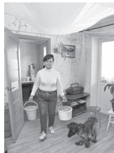
Из-за открытой кровли и весеннего ливня в квартире Оксаны ПЛОТНИКОВОЙ провисли навесные потолки. Откачивать воду ей пришлось за свой счёт. Виной всему - затянувшийся на год ремонт дома в 188 квартале
