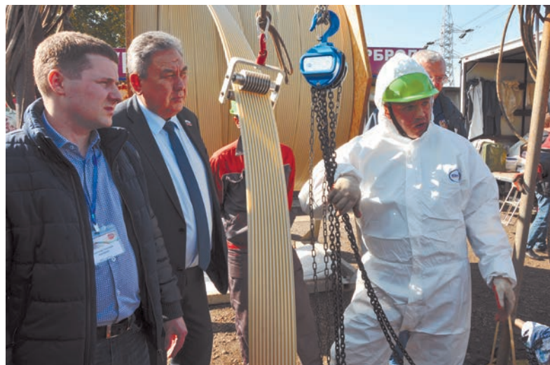
«Ангарский Водоканал» применяет инновационные технологии во время ремонта трубопроводов. На существующую трубу спирально навивается лента из поливинилхлорида - коррозионностойкого материала. Межтрубное пространство заполняется цементосодержащими смесями. Срок службы такой конструкции - 50-60 лет
