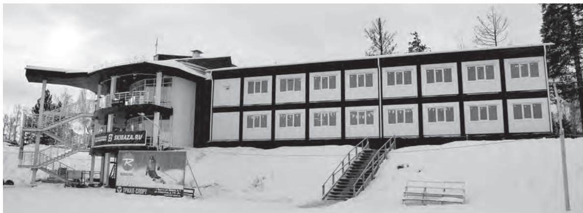
Уже 21 декабря укрупнившийся ЛБК «Ангарский» примет в своих стенах чемпионат и первенство Иркутской области по лыжным гонкам. В полную силу комплекс должен заработать в следующем году
