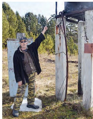
Борис Демко показывает злосчастный трансформатор
