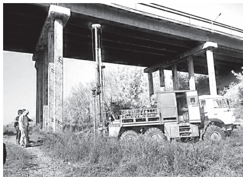
Чтобы «откапиталить» виадук, необходимо сначала выполнить проект и пройти с ним несколько экспертиз. В начале недели подрядчик появился на мосту, точнее, под мостом. Специалисты приступили к первому этапу - геологическим испытаниям
