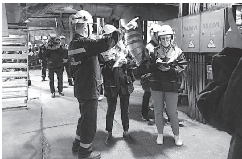
На обзорной экскурсии нам показали, как идёт работа в котельном и турбинном цехах, цехе топливоподачи, на главном щите - центре оперативного управления станцией
