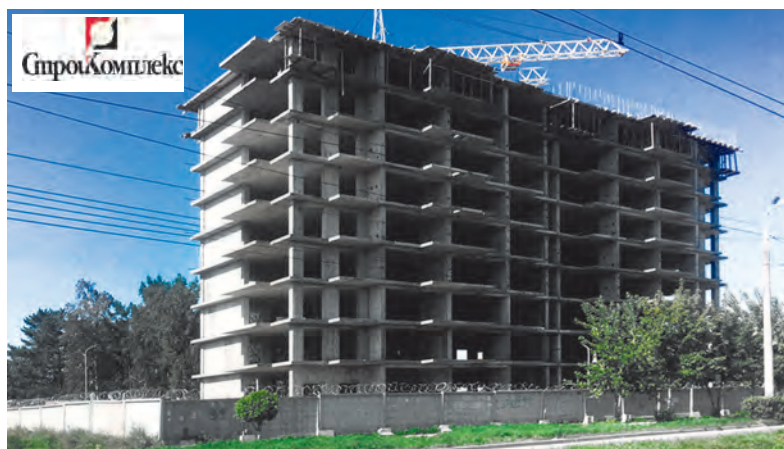
Квартиры от 809 000 рублей в ЖК «Современник», который активно строится в 22 микрорайоне
