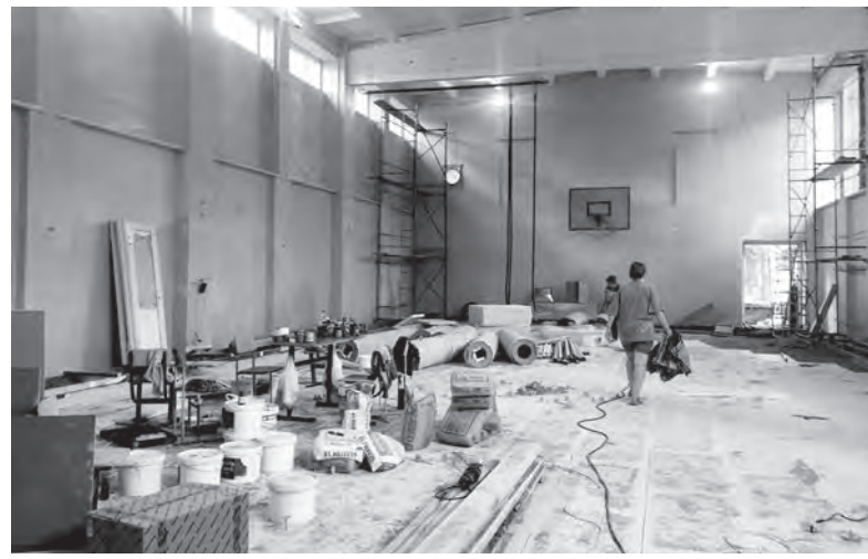
В школе №36 полностью переоборудован спортивный зал на первом этаже. Закончить работы подрядчик должен к 23 августа
