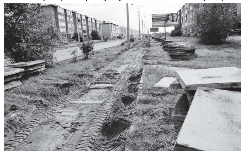
Пока идёт замена субподрядчика, бригады, начавшие ремонт, исправляют свои ошибки
