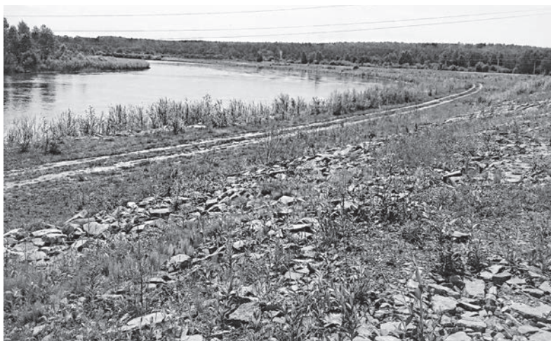
В 2014-2015 годы были выполнены работы по восстановлению существующей дамбы в селе Одинск. Теперь защитное сооружение прекрасно справляется со своими функциями
