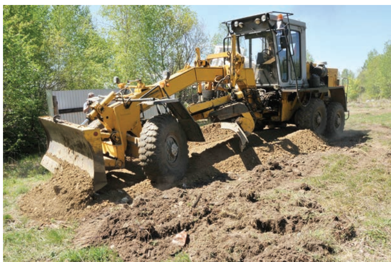
Одновременно с грейдированием дорог идёт установка новой контейнерной площадки для сбора мусора
