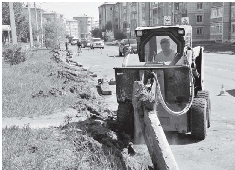
На участке от улицы Радужной до Горького будет выполнен комплексный ремонт. Появится новое дорожное покрытие, подрядчик по контракту должен заменить бордюрный камень, привести в порядок тротуар и решить вопрос с освещением
