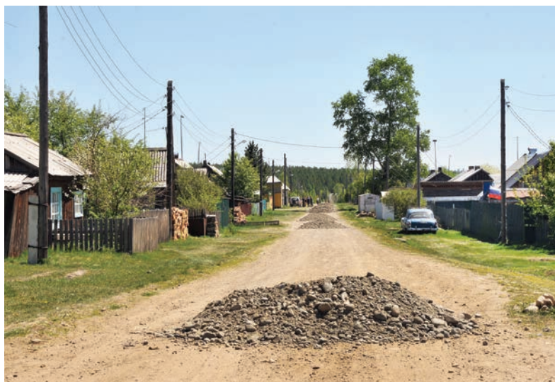
Мы приехали на репортаж и сразу попали на грейдирование дорог. В планах на этот день была ещё установка ограждения вокруг детской площадки. Накануне в посёлке определили места, где нужно пройтись грейдеру, отсыпали ПГС
