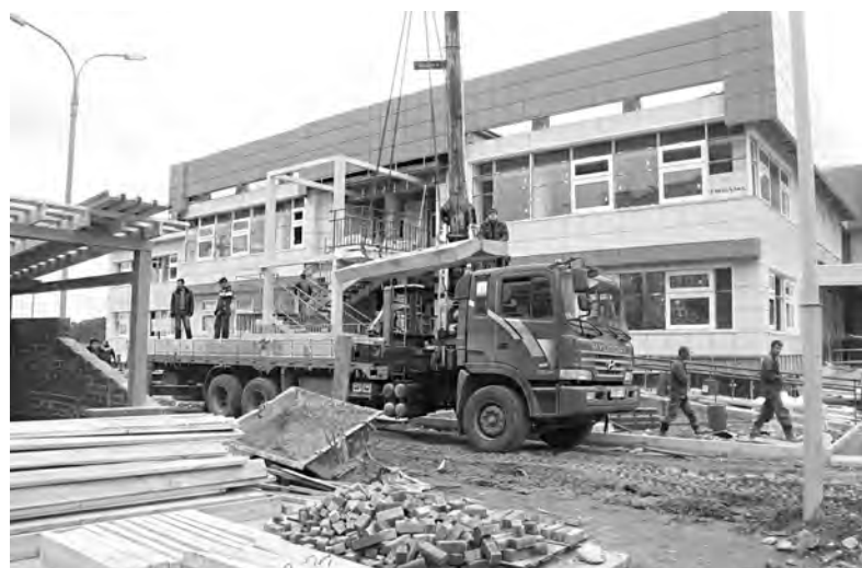
Начали строиться детские сады. Построен детский сад в 32 микрорайоне. В прошлом году начато строительство детского сада в 22 микрорайоне, в этом году начнутся работы по завершению долговострой - детского учреждения в 17 микрорайоне
