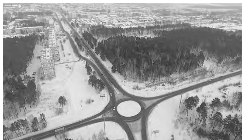
Идёт плановый ремонт, реконструкция и даже строительство новых дорог, развязок
