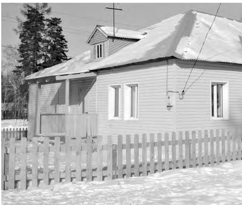
Строители отремонтировали фасад и кровлю, привели в порядок внутренние помещения и коммуникации, установили пожарно-охранную сигнализацию и благоустроили прилегающую территорию
