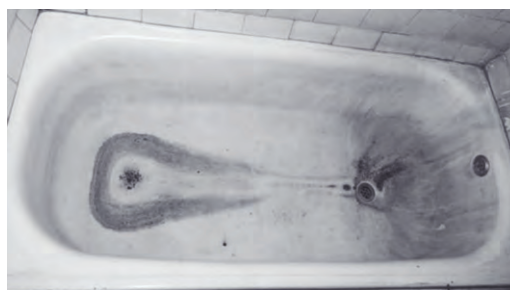
До установки акрилового вкладыша в ванну
