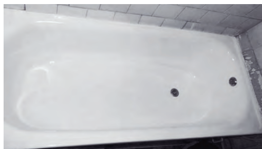
После установки акрилового вкладыша в ванну
