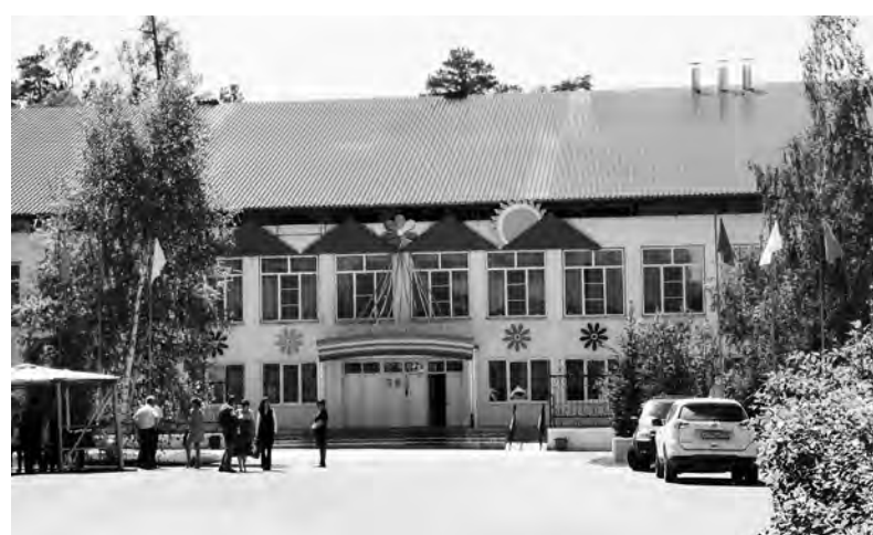
В столовой лагеря «Здоровье» проведено обустройство скатной кровли
