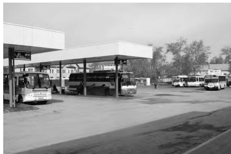
Посадочные платформы - под навесами, установлены скамейки и современные электронные табло. Теперь пассажиры междугородних и дачных маршрутов могут ожидать свой автобус в комфортных условиях
