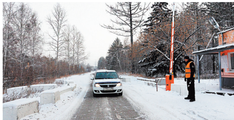
К концу недели специалисты демонтируют шлагбаум и уберут бетонные блоки
