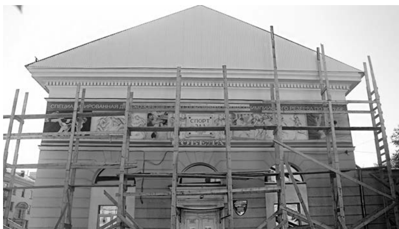
Лепные украшения портика были выполнены из гипса. За 60 лет материал разрушился: от крыши откалывались куски, падали вниз, а это как раз над входом в школу
