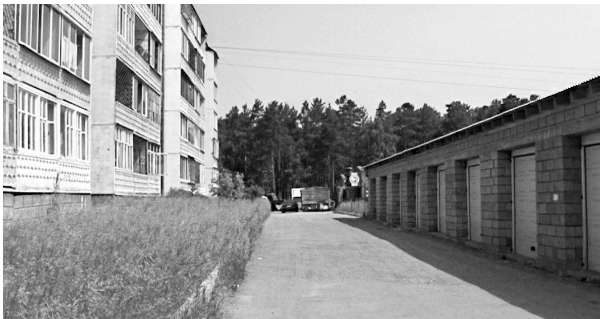
Точку в этой истории суд поставил 21 июня. Постройка была признана самовольной, и арендатор земельного участка обязан снести гаражи и здание
