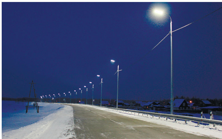
Диодные светильники могут работать и при температуре минус 65 градусов (участок федеральной трассы «Вилуй», Республика Саха (Якутия))
