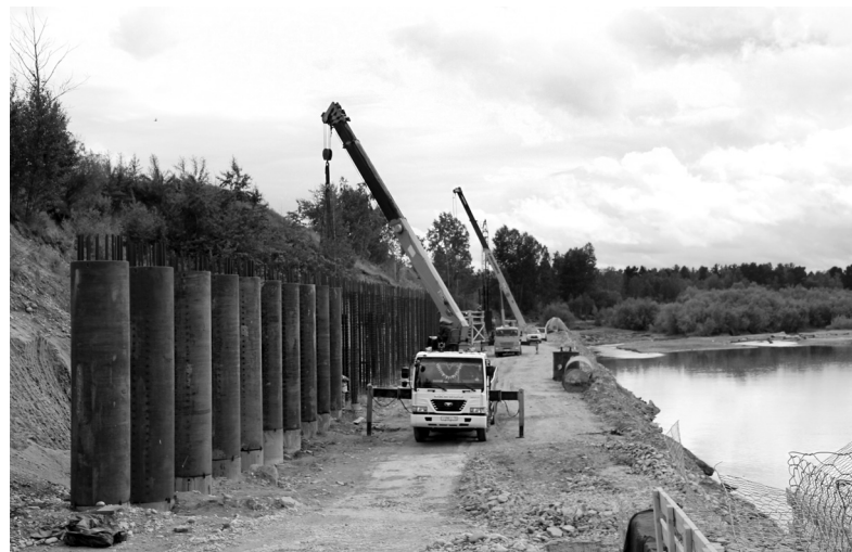
В настоящий момент сваи уже заняли своё место и рабочие осуществляют армирование колоннады
