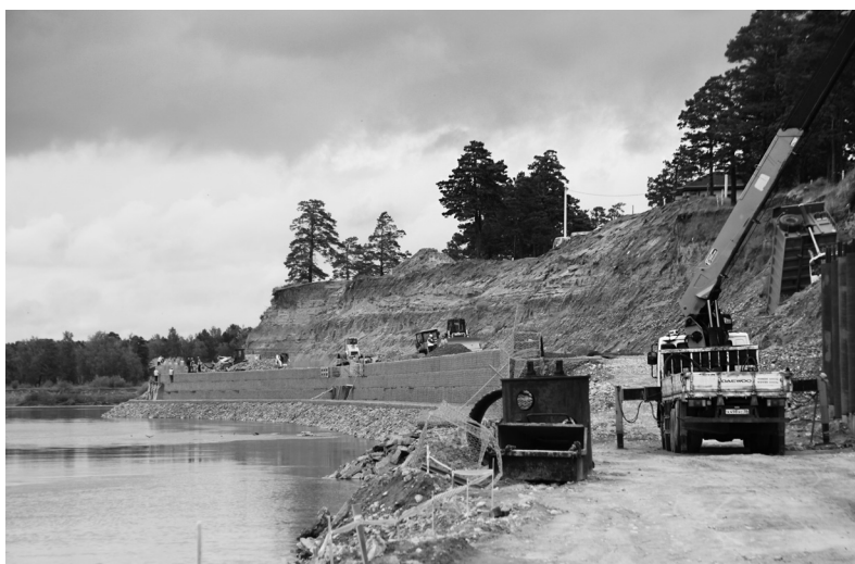
Сегодня из шести предполагаемых ярусов габионных конструкций готовы уже четыре!
