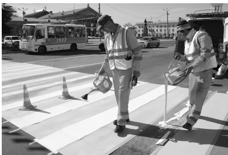
Холодный пластик, которым наносится пешеходный переход, обладает повышенной износостойкостью
