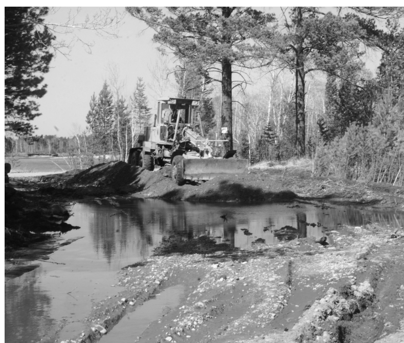
Участок дороги к СНТ «Ясная поляна» в эти дни прокладывают в обход береговой линии
