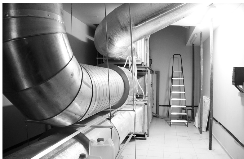
Мощная воздушная система охлаждения «спасает» лампы, температура которой достигает 400 градусов
