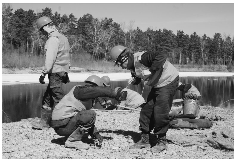
Работники «Сибна» шьют габионные матрасы
