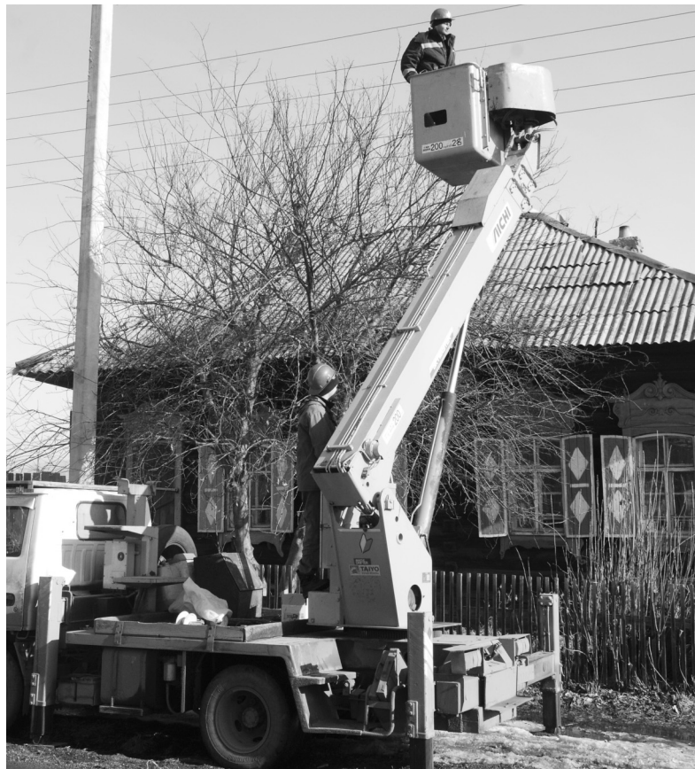
При реконструкции электросетей посёлка Мегет и деревни Зуй был использован современный самонесущий изолированный провод
