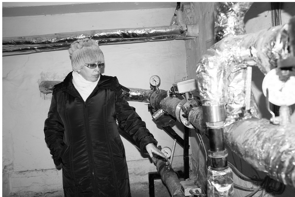
18 микрорайон, дом 1. Одно из мероприятий по энергоресурсосбережению - установка на тепловом узле циркуляционных насосов, которые позволяют и тепло экономить, и деньги жителей
