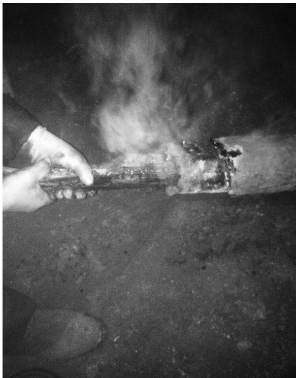
Лилия МАТОНИНА Фото предоставлено МУП «Ангарский Водоканал»
