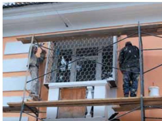
В этом году отремонтировали 18 многоквартирных домов
