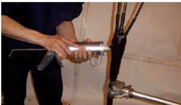
Рис. 11. Монтаж концевой муфты серии Scotchcast™ 92-ОТ, выполненной на основе RPM-технологии
