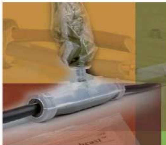
Рис. 3. Заливка компаунда Scotchcast™ внутрь корпуса муфты
