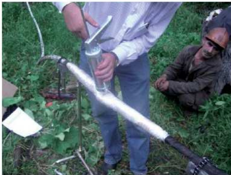
Рис. 9. Монтаж соединительной муфты серии Scotchcast™ 92-OT, выполненной на основе технологии нагнетания компаунда под давлением
